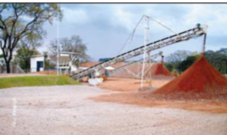
Central de Reciclagem de Entulho
